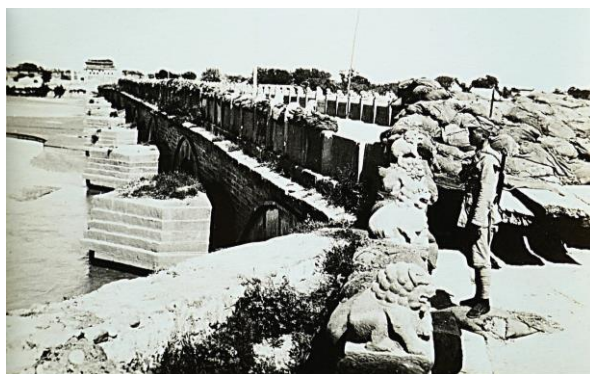
Die mit Sandsäcken abgeriegelte Marco Polo Brücke
