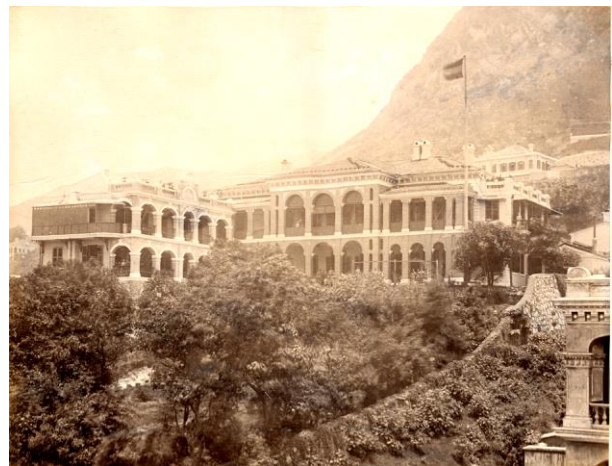
Das „Berliner Findelhaus“ in Hongkong, um 1900
