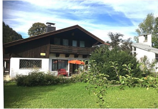
Blick vom Garten auf das Haus
