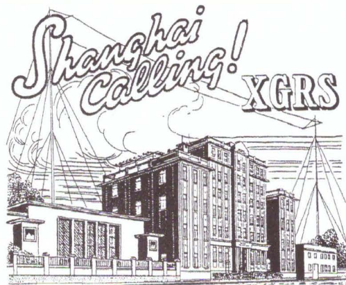
KWS, Kindergarten und Radiostation befanden sich in einem Gebäude (3 Great Western Road)
