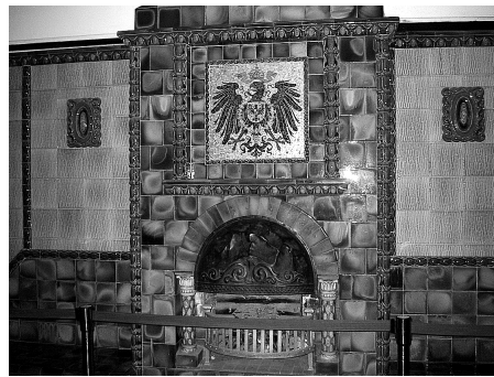
Kamin in Eingangshalle des Tsingtau-Klubs
