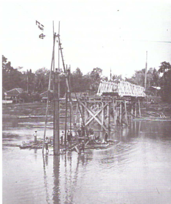
Die Brücke über den Ogan im Bau, 1928
