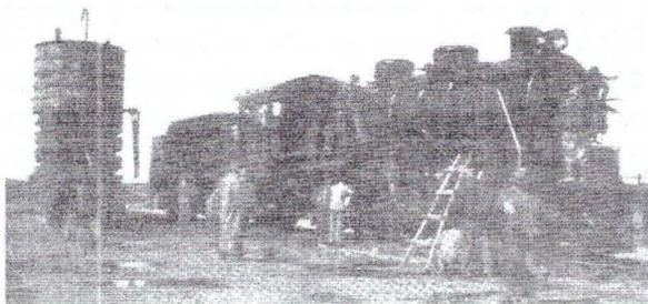
Betriebswerk an der Chekiang-Kiangsi-Bahn. Wasserturm (zur Versorgung der Lokomotiven) und Montage einer Henschellokomotive
