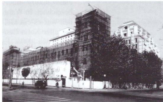
Das Astor Hotel wird renoviert Tianjin, 21. November 2009
